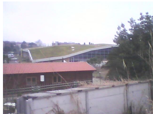
Piscina in costruzione "Vasca Navale".
