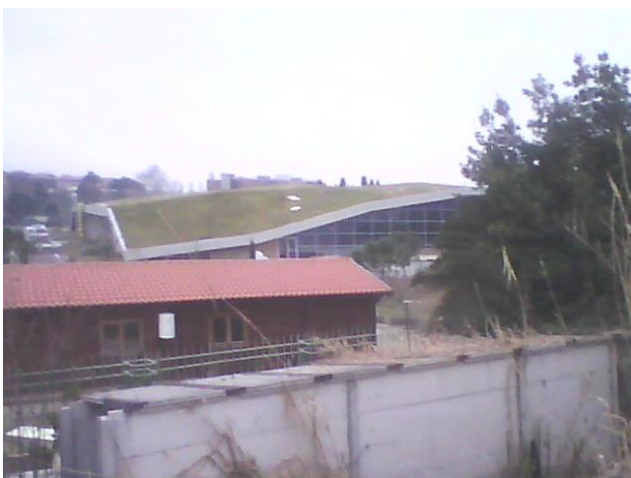
Dietro, il cantiere della piscina da altra prospettiva.
