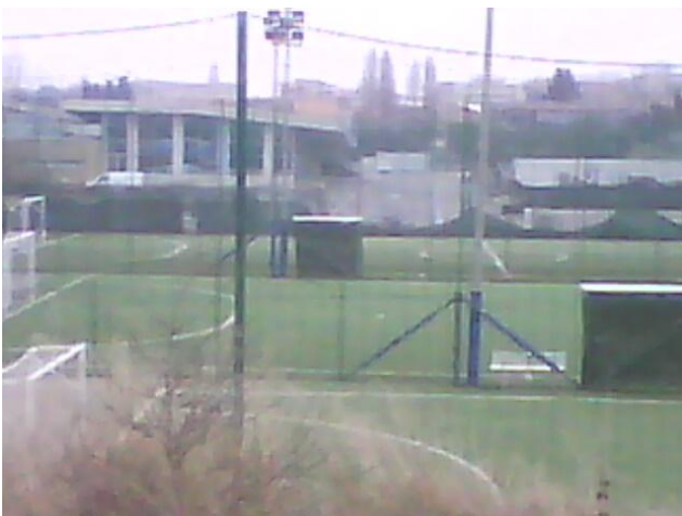
In lontananza si vede il cantiere della piscina fermo dal 2009.
