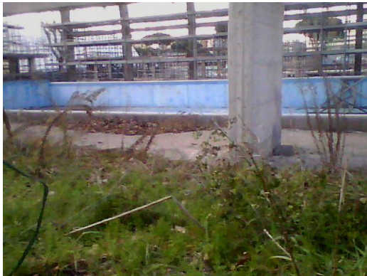
Piscina in costruzione "Fiera Roma".
