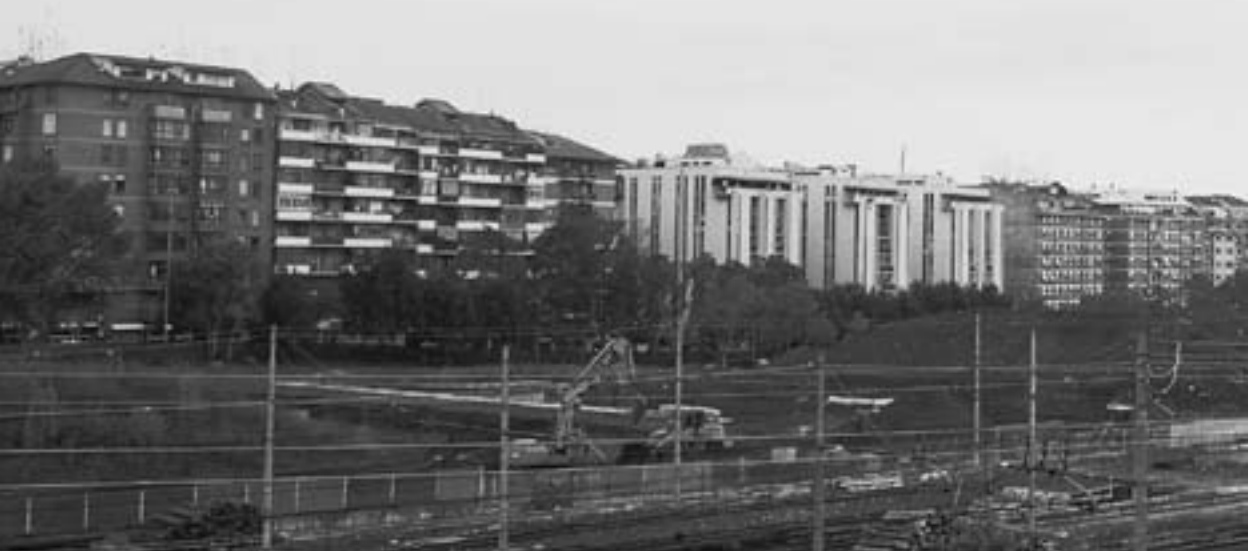
Fig. 34 - Veduta di grandi lavori in atto nell'area prospiciente la stazione Ostiense e il «Campidoglio Due», 2007, CROMA-CeDOT.
