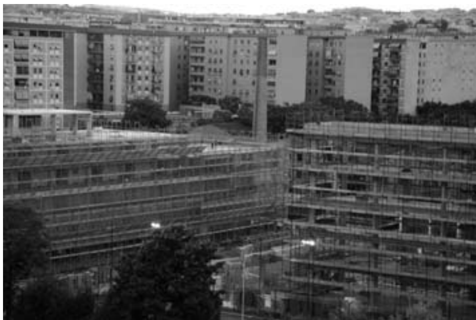
Figg. 29 e 30 - Veduta dall'edificio degli ex-Consorti agrari (ora Città del gusto) di imponenti costruzioni in atto su aree ex-industriali sulla sponda destra del fiume, in parte anche sul sito dell'ex-Mira Lanza. Assai improvvida appare la scelta di occupare con un'edilizia intensiva i pochi spazi disponibili in zona Marconi e di annullare il profilo di archeologia industriale di questa riva del Tevere prospiciente l'exporto fluviale. 2007, CROMA-CeDOT.
