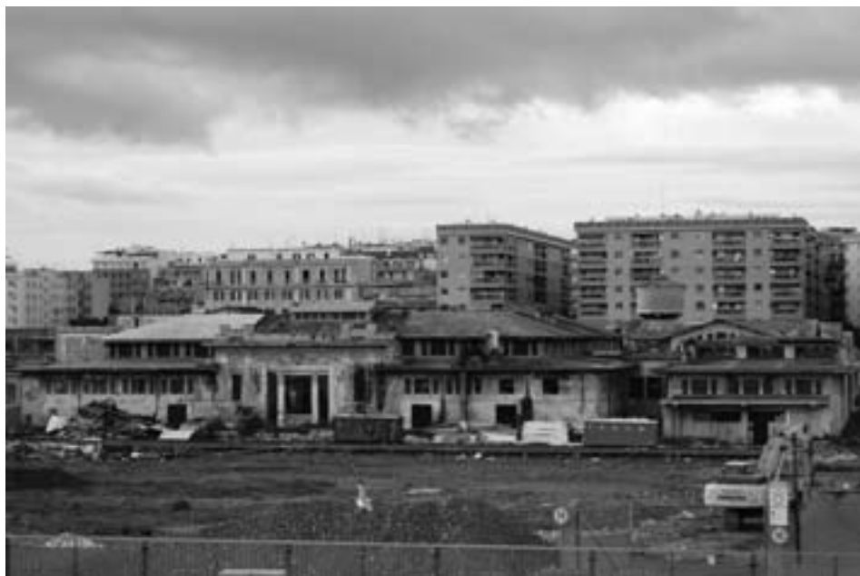
Fig. 31 - Veduta (da sud) del sito degli ex-mercati generali a lavori di demolizione già avviati, 2007, CROMA-CeDOT.
