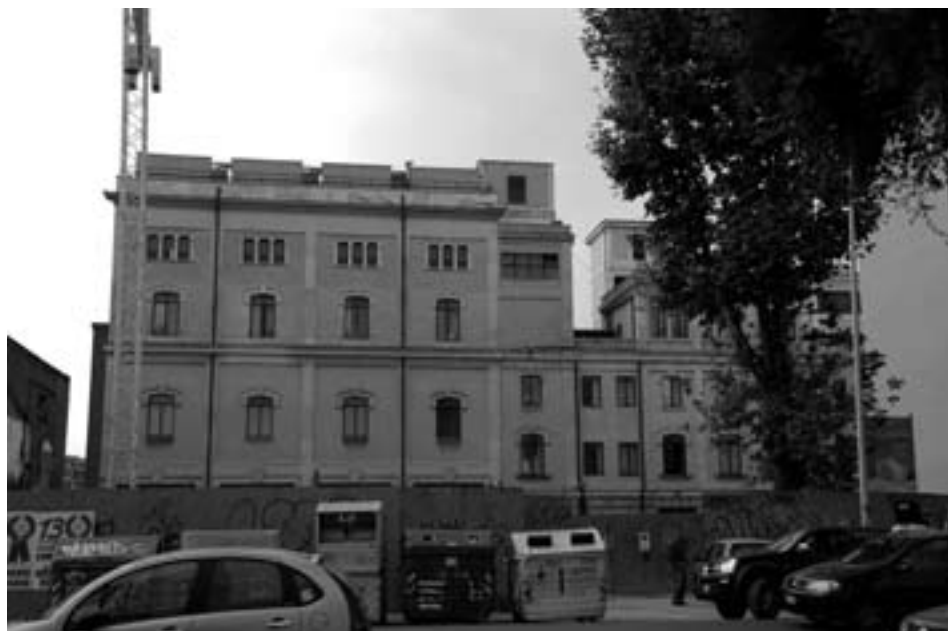
Fig. 35 - Veduta dei lavori di costruzione di un nuovo edificio sul sito di una costruzione d'epoca di modesto volume (demolita). Il nuovo edificio, di forme architettoniche estranee al contesto e assai discutibili, verrà sostanzialmente a precludere la vista dalla via Ostiense del profilo del Museo dell'ex-centrale Montemartini, 2007, CROMA-CeDOT.
