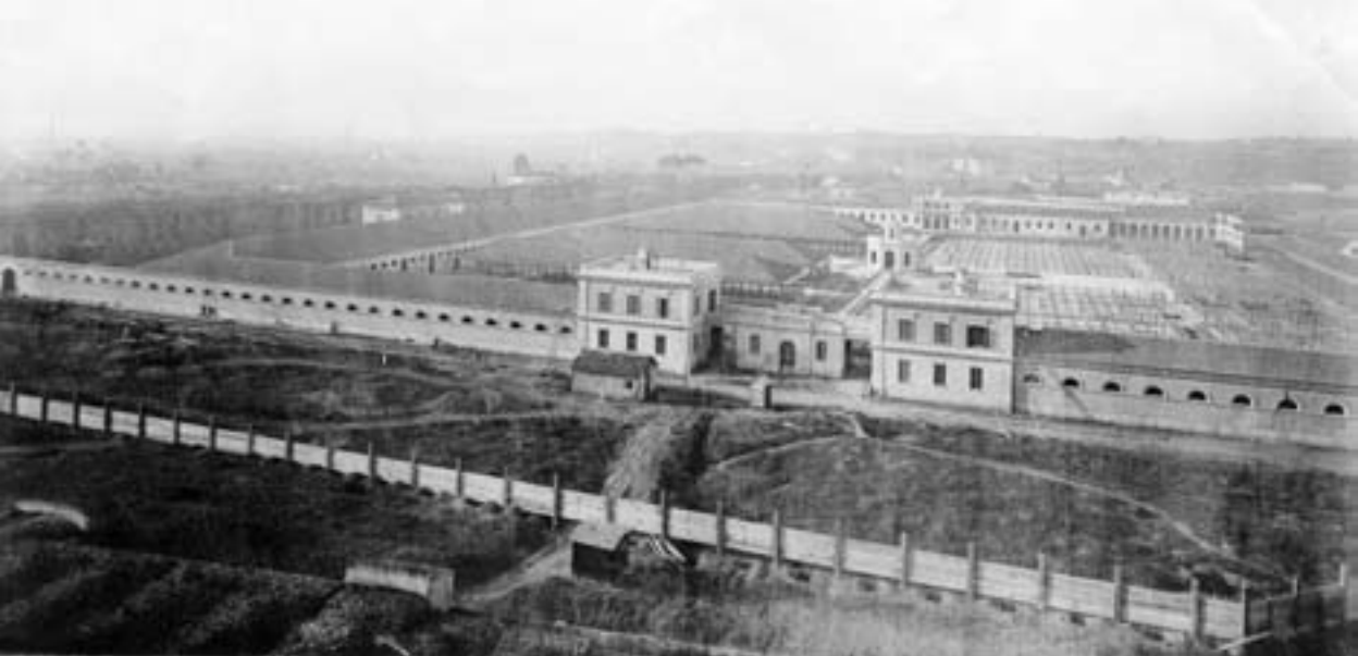
Fig. 9 - Il Mattatoio in costruzione. Veduta generale presa dal monte Testaccio, 1890 ca., Archivio Storico Capitolino.
