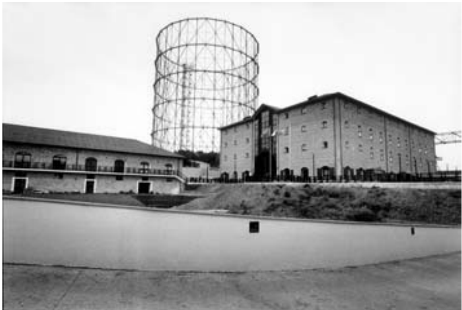
Fig. 26 - Giulio Napolitano, Veduta degli ex-magazzini generali, ora sede dell'Istituto Superiore Antincendi, 2004, CROMA-CeDOT.
