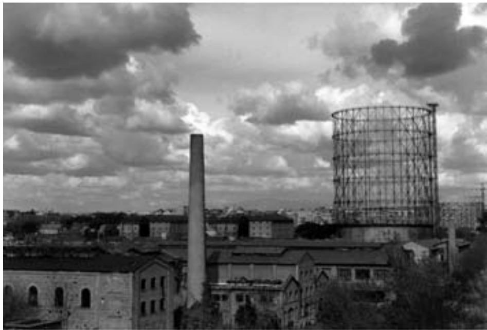
Fig. 13 - Veduta degli stabilimenti Mira Lanza sulla sponda destra del Tevere, 1967 ca., CROMA-CeDOT.
