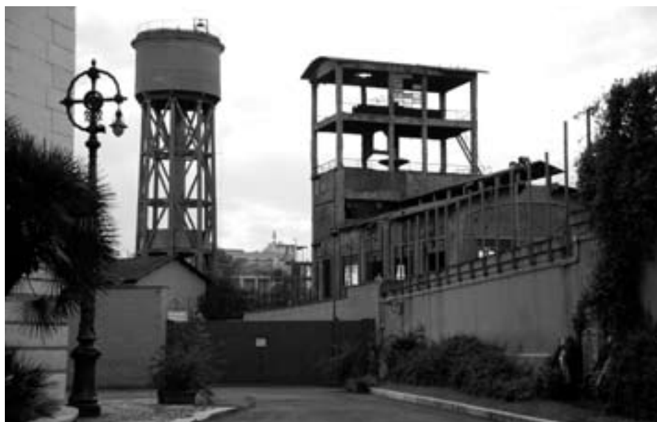
Fig. 36 - Veduta del portone di accesso alla nuova centrale termoelettrica ACEA, sullo sfondo infrastrutture della confinante area ENEL e ENI, 2007, CROMA-CeDOT.
