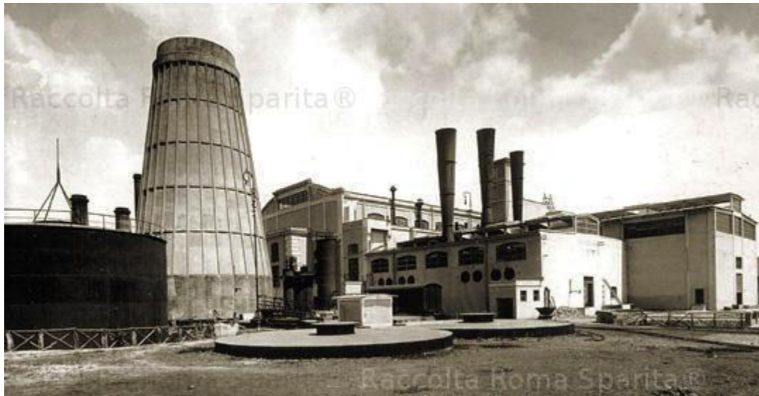
1924 – Centrale elettrica Montemartini.
