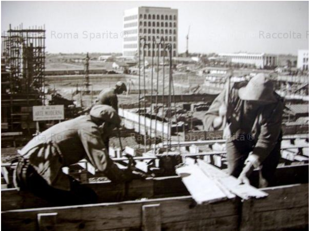
1935 – Lavori in corso all'EUR.
