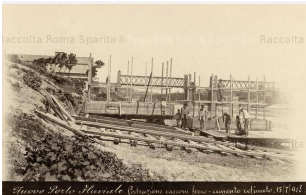
1908 – Porto Fluviale. Lavori in corso.
