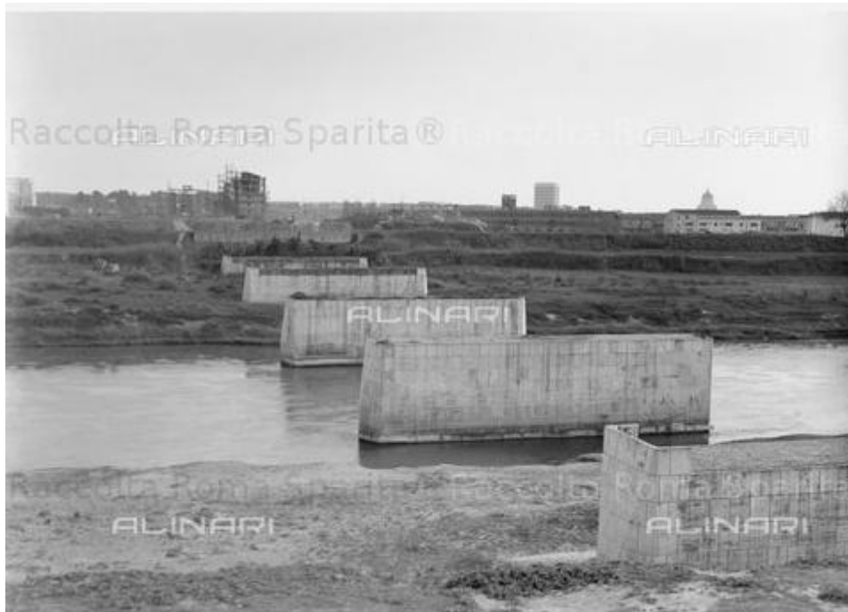
1937/38ca. – Ponte Marconi in costruzione.
