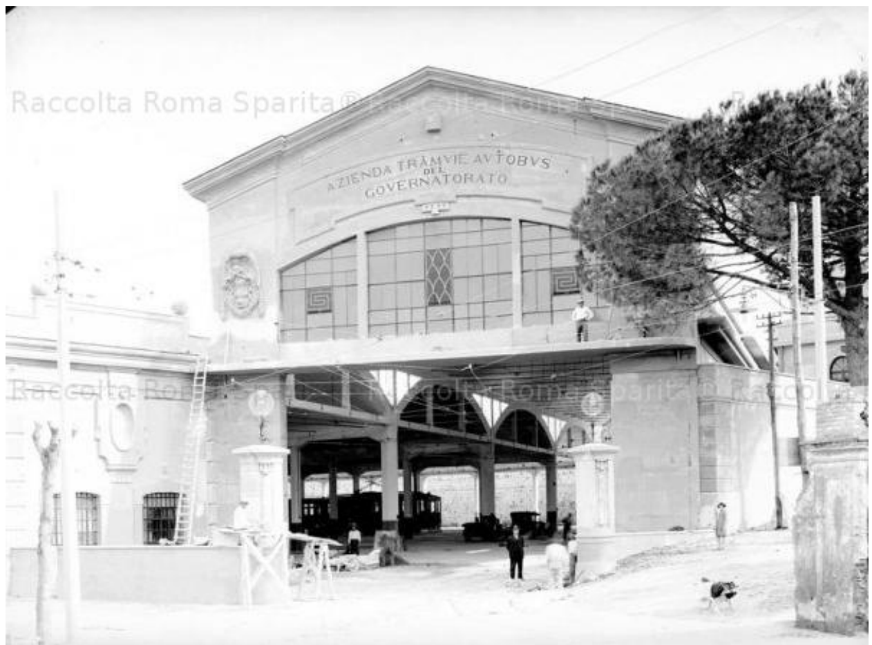
1940 – San Paolo. Via Alessandro Severo, il deposito ATAG.
