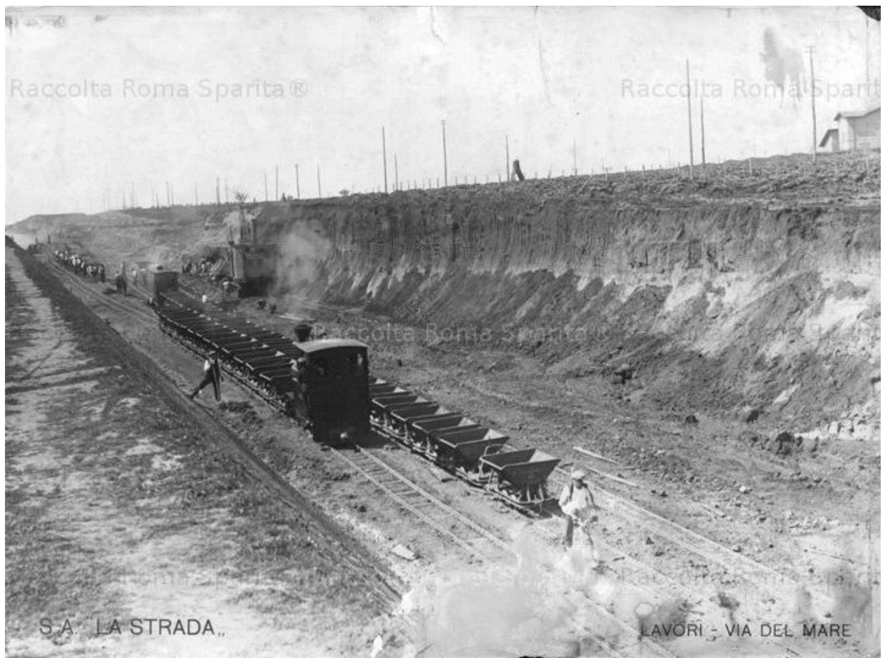
1900 - Via del Mare in costruzione.
