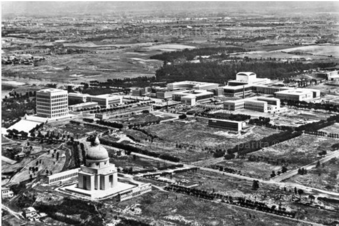
1930ca. - Eur in costruzione.
