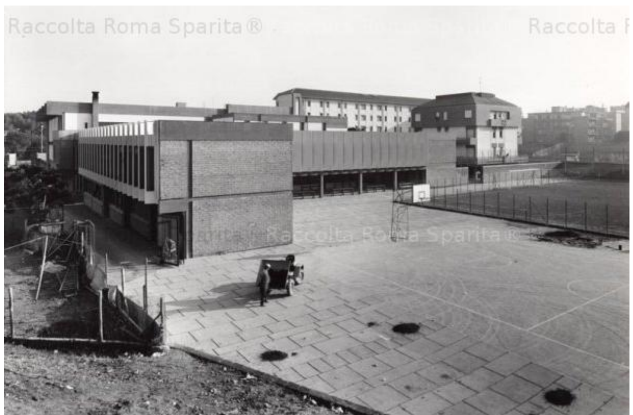
1966/69 – Oratorio San Paolo Ostiense in costruzione.
